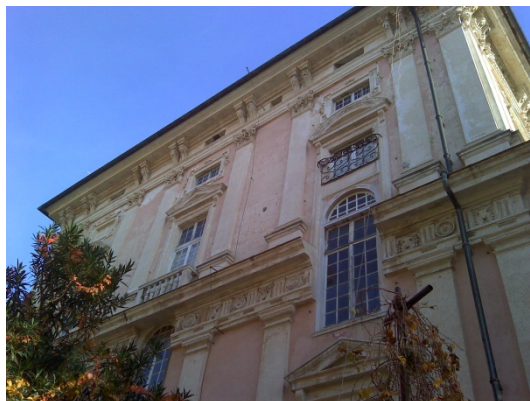
Figura 1.1 - Vista della facciata esposta a Ovest
